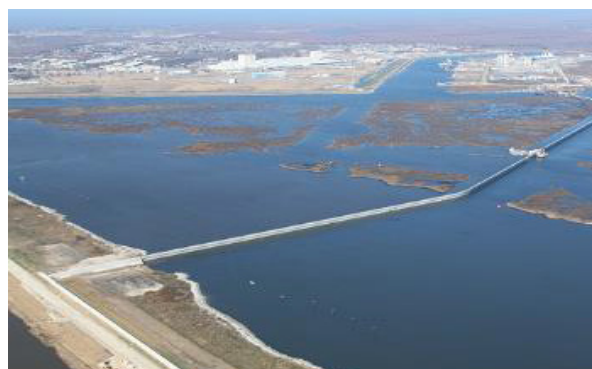
Digue en zone estuarienne
