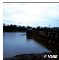
BARRAGE DE VEZINS
