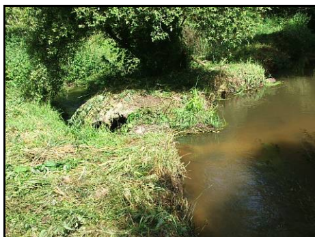
Aperçu de la brèche depuis le bief.
