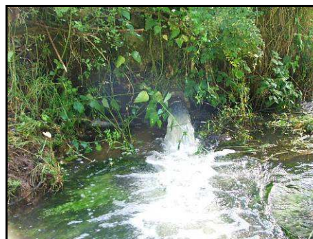
Vue du dispositif de prise d'eau pour l'alimentation d'un étang.
