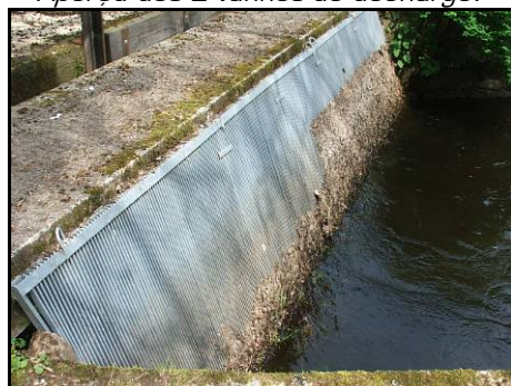
Les grilles à l'amont des vannes offrent un espacement de 1 cm entre les barreaux qui ont une largeur de 6 mm.
