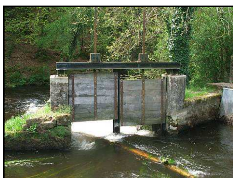
Aperçu des 2 vannes de décharge.
