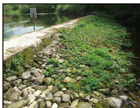
Vue du déversoir depuis l'aval.
