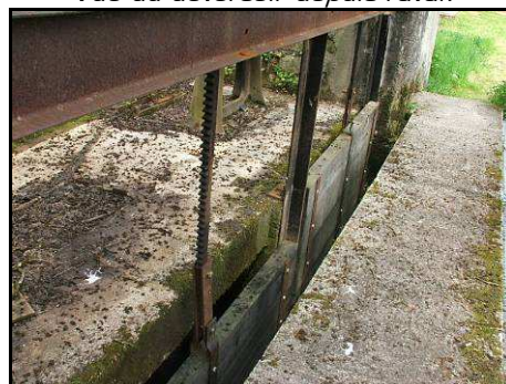
Vue des 2 vannes de prise d'eau des turbines.
