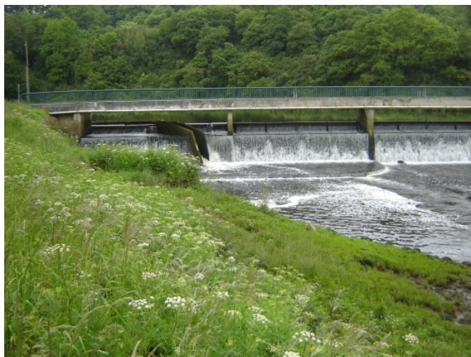
Photo n°12 : Barrage de Goaz-Vilinic équipé en rive droite d'une passe à ralentisseurs
