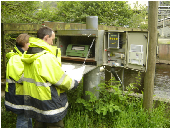
Photo n°5 : Appareillage de la station de jaugeage du moulin de Chateaulin
