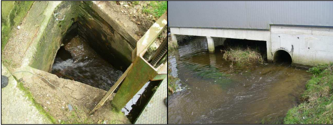
Entrée et sortie de l'ancienne vanne usinière actuellement utilisée comme vanne de décharge
