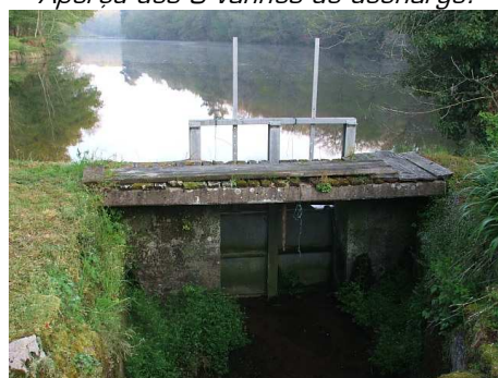
Vue des 2 vannes de prise d'eau du moulin.
