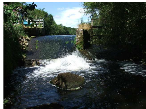
Vue du déversoir depuis l'aval.
