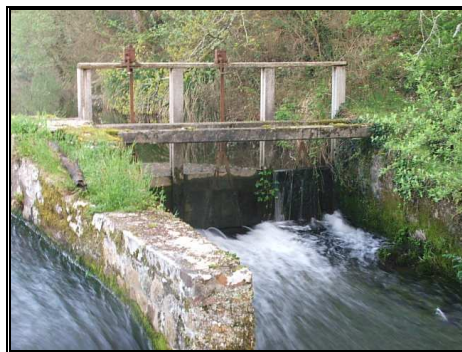
Aperçu des 3 vannes de décharge.
