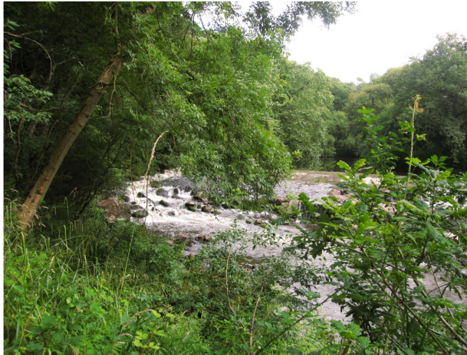
Photo n°13 : Déversoir du Moulin de Châteaulin muni d'une échancrure en rive droite
