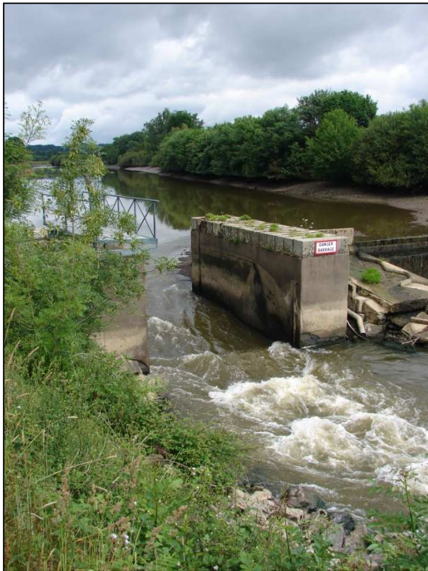
Clapet de Malon abaissé le 02 juin 2010.
