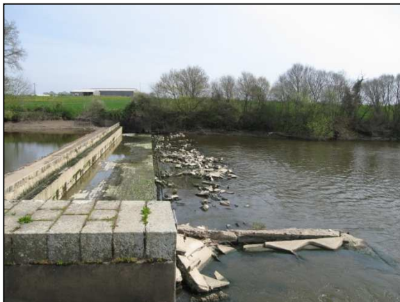
Seuil du barrage à sec le 21 avril 2010
