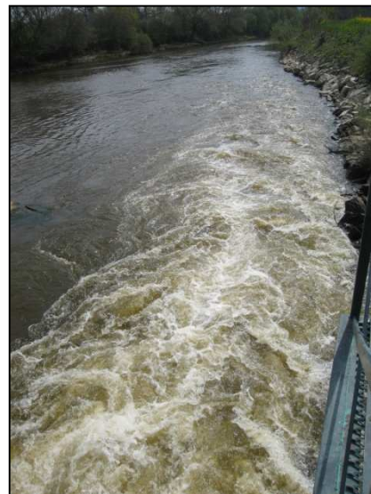
Remous en aval du clapet abaissé le 21 avril
