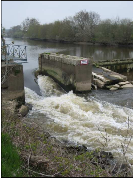
Dénivelé supérieur à 1m et remous importants à l'aval du clapet.
