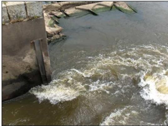
Écoulements au droit du clapet
