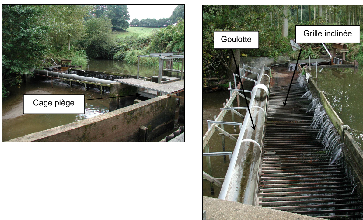
Figure 2 : Vue générale du dispositif de piégeage des smolts
