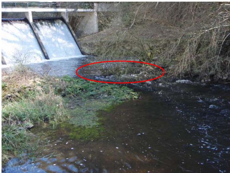
Les niveaux de l'eau en amont et en aval de ce seuil étaient respectivement de 2.21 m (mesure prise au pied du barrage) et 2.02 m (mesure prise près de la buse à l'aval de la station).
