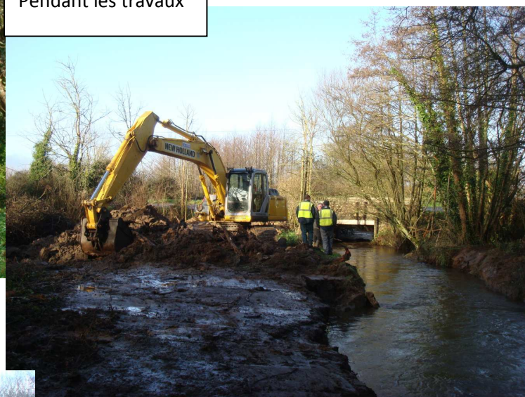
Pendant les travaux
