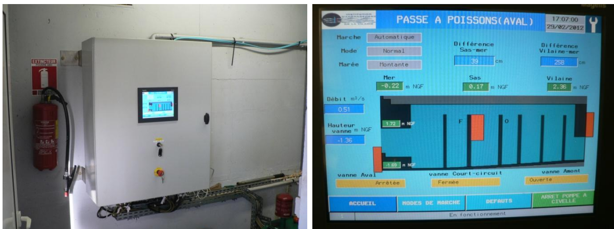
Photos 6 et 7.- Armoire électrique aval et panneau électronique de contrôle de la passe à bassins.
