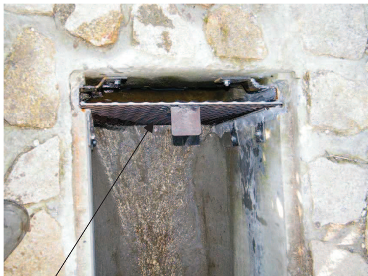
Batardeau dans la chambre d'entrée de la goulotte
