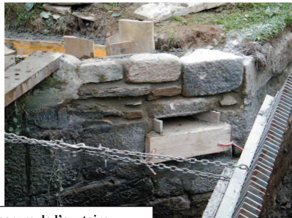
Maçonnage de l'échancrure de l'exutoire
