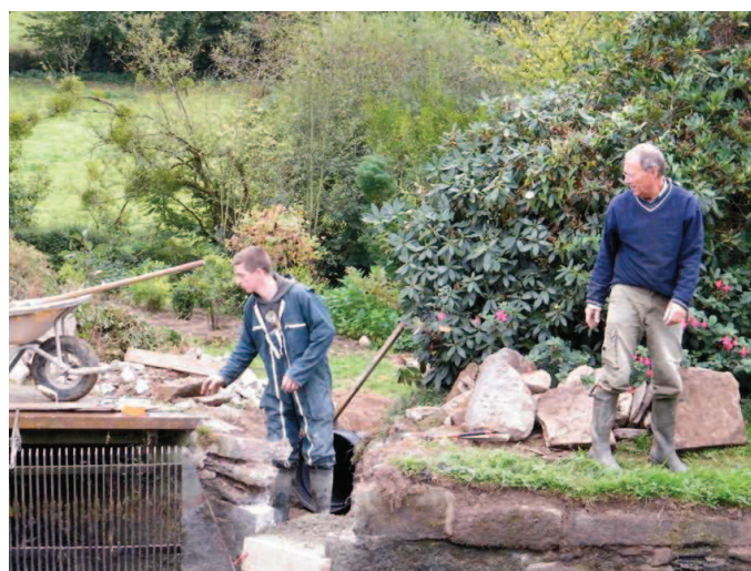
Démontage du mur du bief
