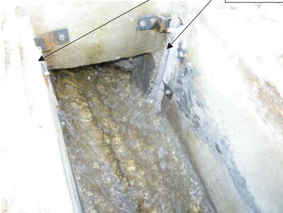
Glissières du batardeau dans la chambre d'entrée de la goulotte
