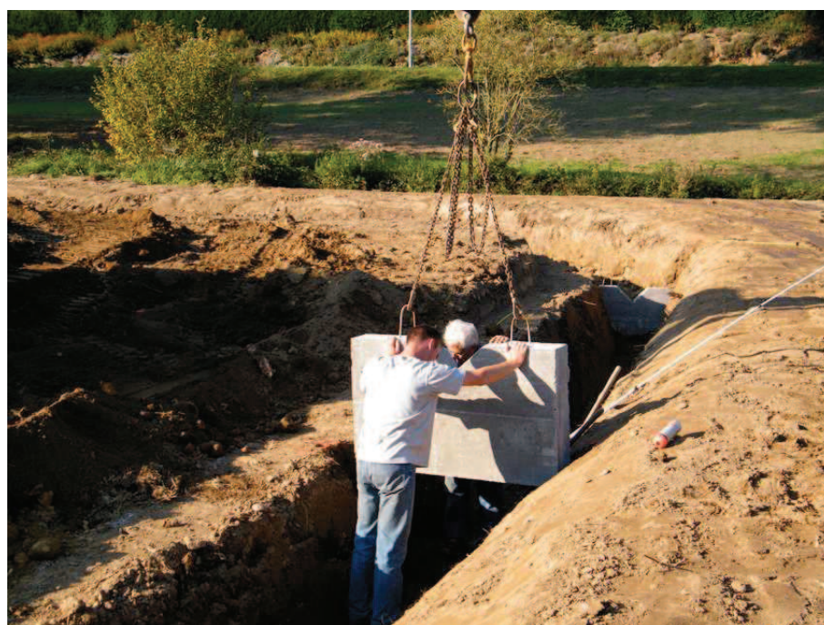
Mise en place du 4 ème mini-seuil
