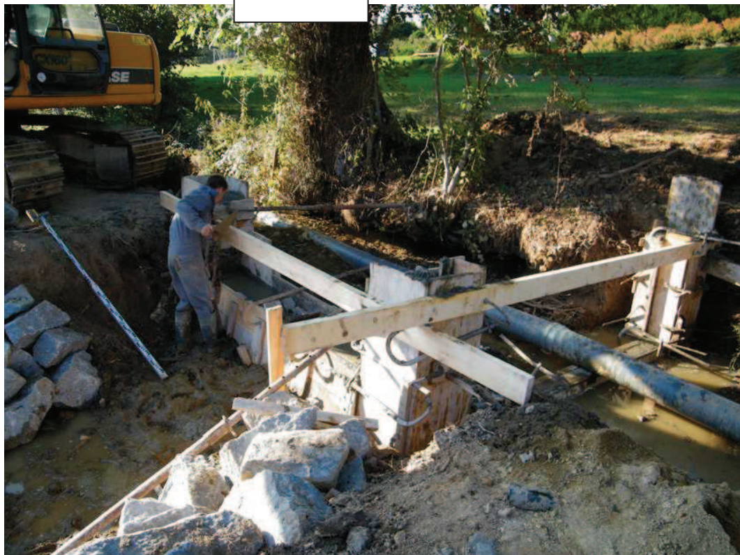
Coulage du béton sur le déversoir
