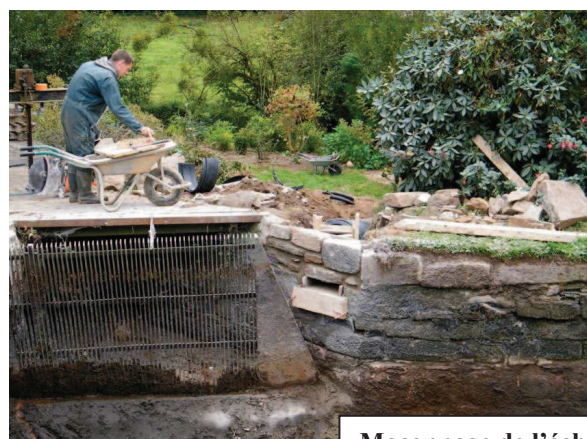
Maçonnage de l'échancrure de l'exutoire
