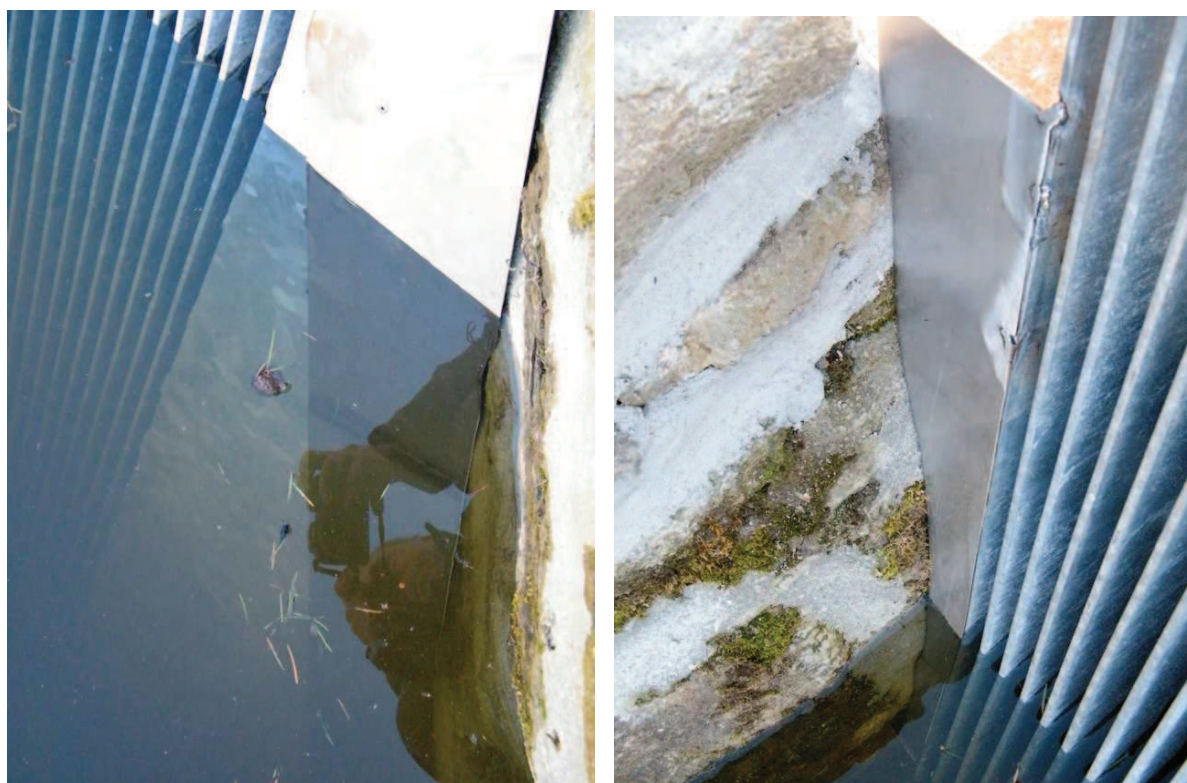
Flasques latéraux ajustés le long des murs du bief
