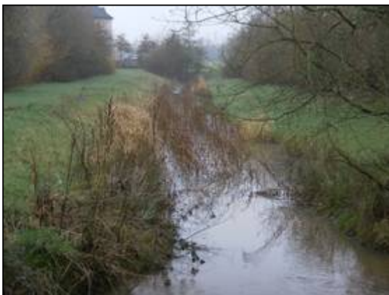
Vue du fossé amont, situé le long de la route de Pont Amelin.
