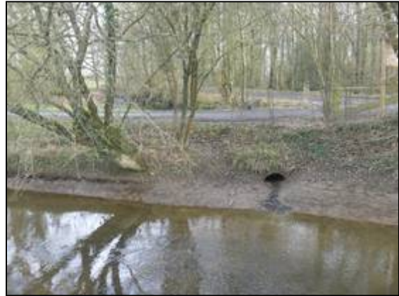
Vue du passage busé envasé permettant une connexion hydraulique avec l'annexe. Les connexions biologiques sont compromises par l'envasement.
