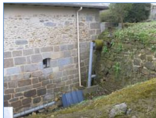
Vue de l'emplacement de l'ancienne roue du moulin. Les écoulements par les deux buses condamnées sont récupérés par des tuyaux PVC.
