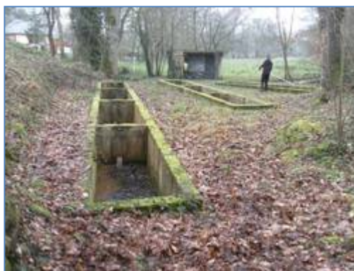
Vue des bassins en béton permettant de stocker les poissons.
