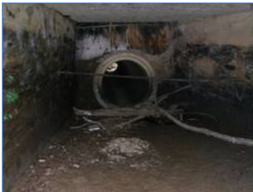
Passage busé de diamètre 800 mm sous la voie d'accès aux logements situés entre le bief et la Flume.
