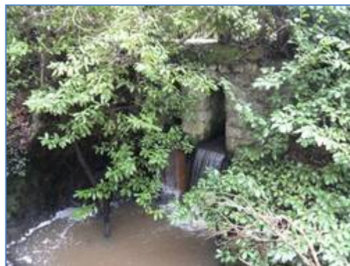
Vue de la chute aval de l'ouvrage de décharge par débit faible
