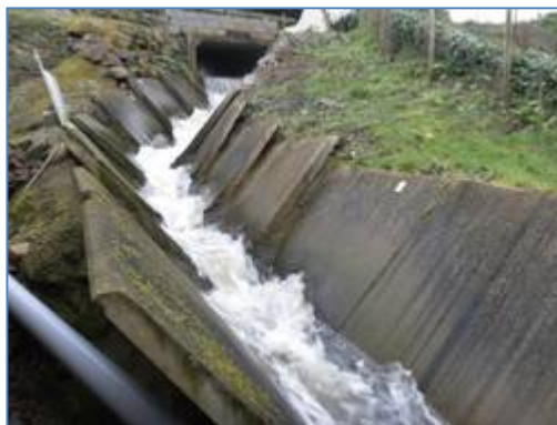
Vue des modules trapézoïdaux implantés en aval du pont cadre depuis l'aval.
