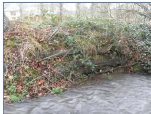
Ancienne brèche dans le talus au niveau du profil en travers T1 colmatée par des troncs.
