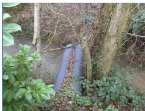
Vue de la partie aval des buses de trop-plein.
