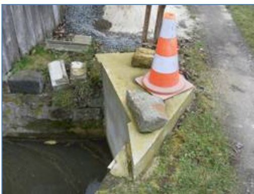
Vue de l'amont de l'ancienne prise d'eau pour l'alimentation du moulin.
