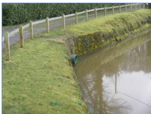
Vue des buses de trop-plein depuis l'amont.
