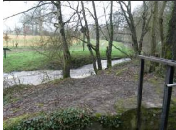
Vue des écoulements par le déversoir de décharge (anciennes vannes en position fermée) 22 février 2011).
