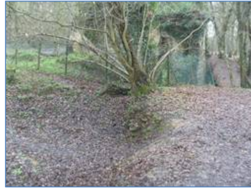
Le canal d'améné au moulin est complètement obstrué par les sédiments.
