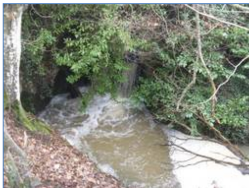
Vue de la chute aval de l'ouvrage de décharge par débit soutenu
