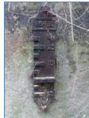
Repère en fonte disposé en rive droite de la vanne située sur le bief
