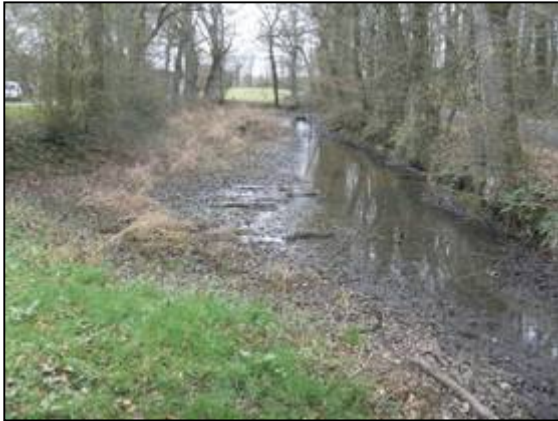
Vue de l'annexe hydraulique située de l'autre côté du chemin d'accès au moulin en rive gauche.
