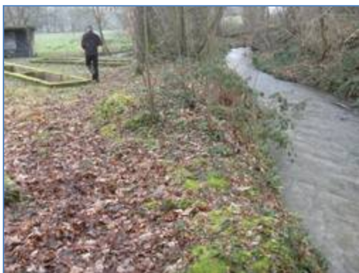
Le talus boisé en rive gauche du bras de décharge est absent immédiatement en aval de la digue du plan d'eau.
