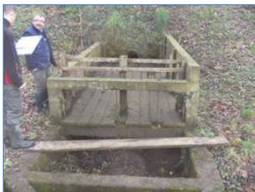
Vue du dispositif de vidange depuis l'aval avec sa pêcherie en bois.
