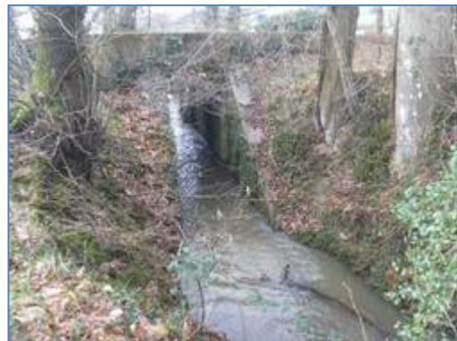
Pont du bras de rive droite sous la voie communale située en aval du plan d'eau
