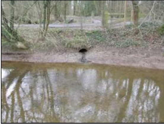
Vue de l'accumulation de sédiments fins dans le bief en amont des ouvrages de décharge (10 février 2011).
