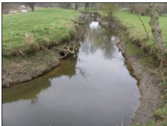
Vue de l'état des berges immédiatement en amont du clapet.
