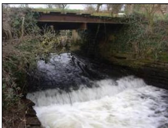
Vue de l'ouvrage en conditions hydrauliques moyennes (10 février 2011).
