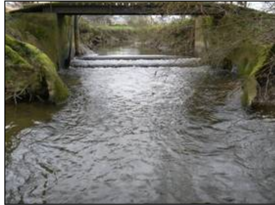
Vue du clapet en position abaissé (février 2011).
