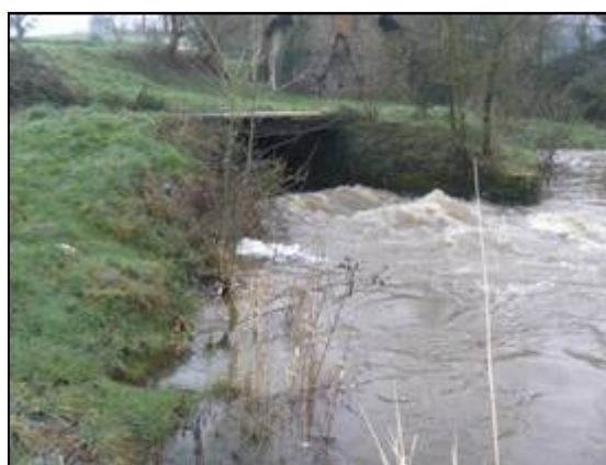
Vue de l'ouvrage lors de débits soutenus (22 février 2011).
