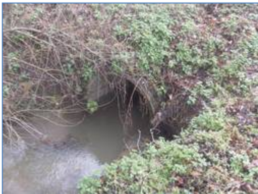
Passage busé du bras de rive gauche sous la voie communale en aval du plan d'eau
