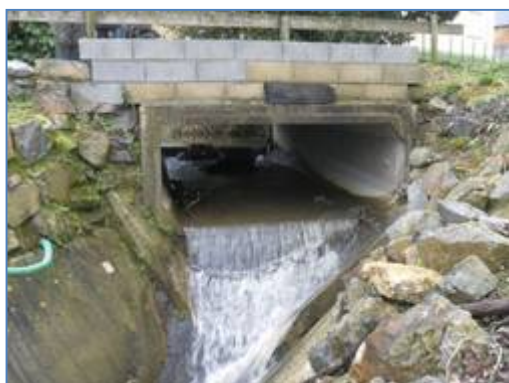
Vue de la chute aval au niveau du pont cadre.
