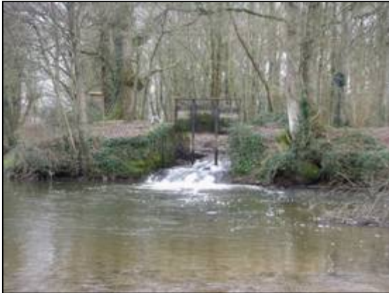
Vue des écoulements par le vannage en position ouverte (10 février 2011).
