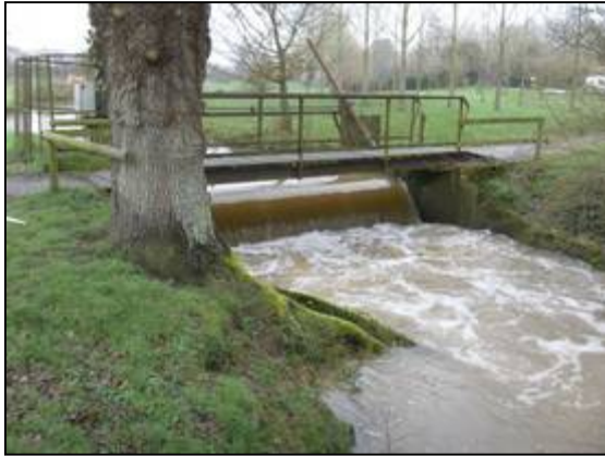
Vue du clapet en position haute (février 2011).
