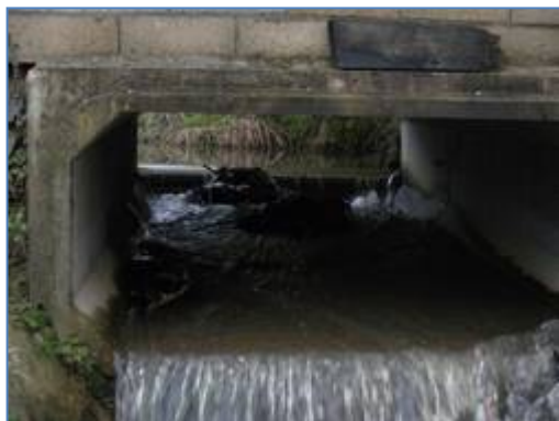
Vue du pont cadre et du batardeau implanté en amont.
