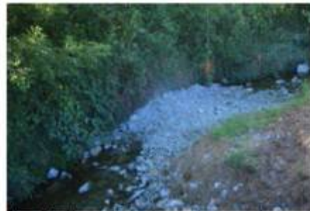
Photo 74 : Clouere finition du second macro-seuil
