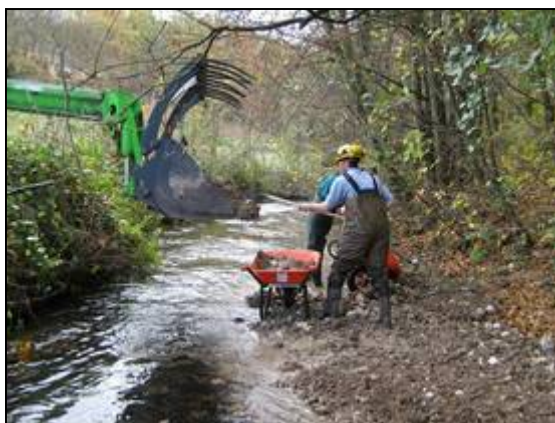
Exemple de création de banquette minérale sur la Remberge (Photos : Fabien LANGUILLE) : avant et pendant les travaux
