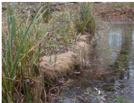
Vue de boudins et de banquettes d'hélophytes permettant de stabiliser les berges et de créer des habitats
