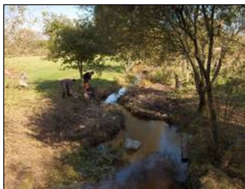
Exemple d'un radier en cours de constitution avec banquettes latérales sur le Langonnet (56) - Photo : Fédération de pêche 56
