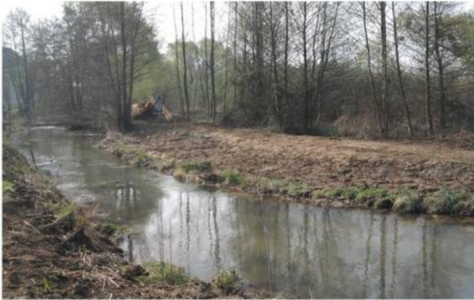
Exemple de création de banquette mixte (enrochements en pied et retalutage de la berge sur la Cisse (41) (Photos : Ludovic COGNARD, Pays Beauce Val de Loire)
