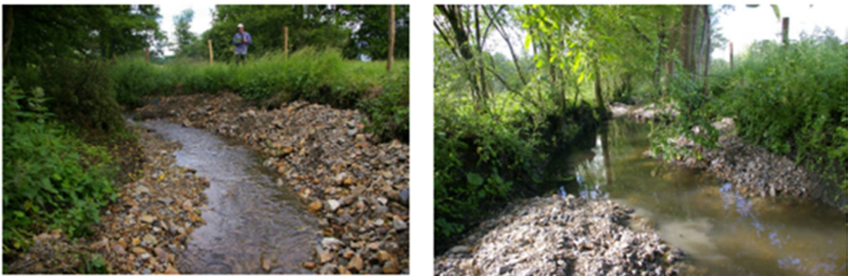
Figure 10 : Principe de la recharge en granulats (source : Etat d'avancement des travaux de protection des populations d'écrevisses à pattes blanches et des frayères à truite fario, Jérôme Jamet (FDAAPPMA 61), 2010)
