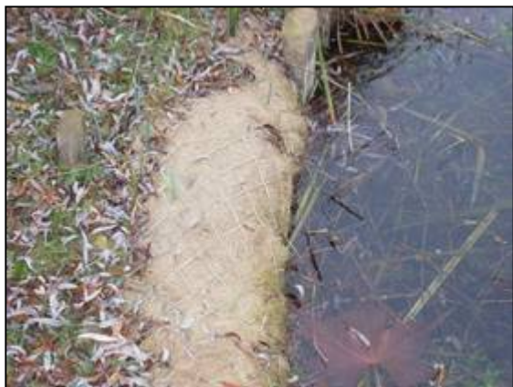
Vue de boudins et de banquettes d'hélophytes permettant de stabiliser les berges et de créer des habitats
