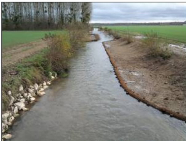
Exemple de réalisation de banquettes permettant de dynamiser le lit du cours d'eau (La Cisse) (Photo : Ludovic Cognard, Pays Beauce-Val de Loire).
