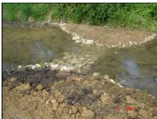
Exemple d'un radier en cours de constitution avec banquettes latérales sur l'Oeuf - Photo : Fédération de pêche 45
