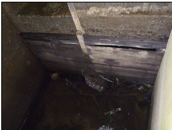
Figure 3 : Aspect du secteur enterré (a) et vanne du partiteur de débit (b)
