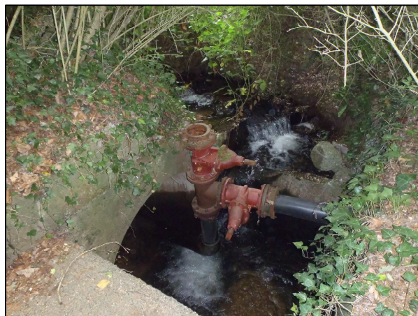
Figure 25 : Prise d'eau dans le bief d'amenée au moulin (gauche), ancien pompage et passage en souterrain (FISH PASS)
