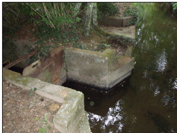
Figure 25 : Prise d'eau dans le bief d'amenée au moulin (gauche), ancien pompage et passage en souterrain (FISH PASS)
