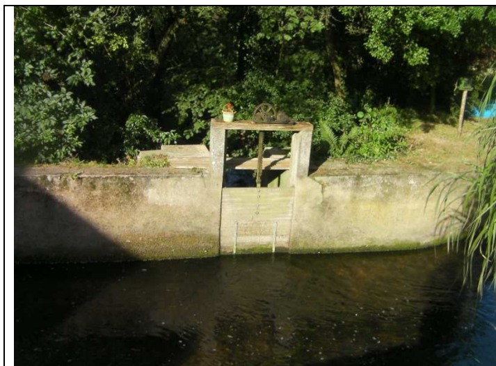
Figure 29 : Vanne de décharge du moulin (FISH PASS)
