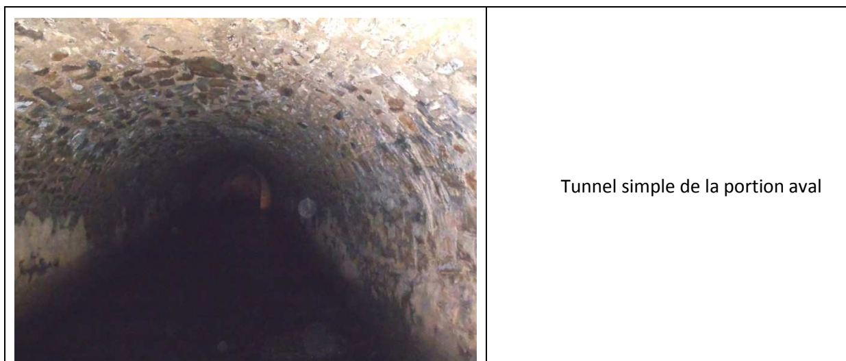
Figure 5 : Tunnel à l'aval de la chambre des vannes (FISH PASS)
