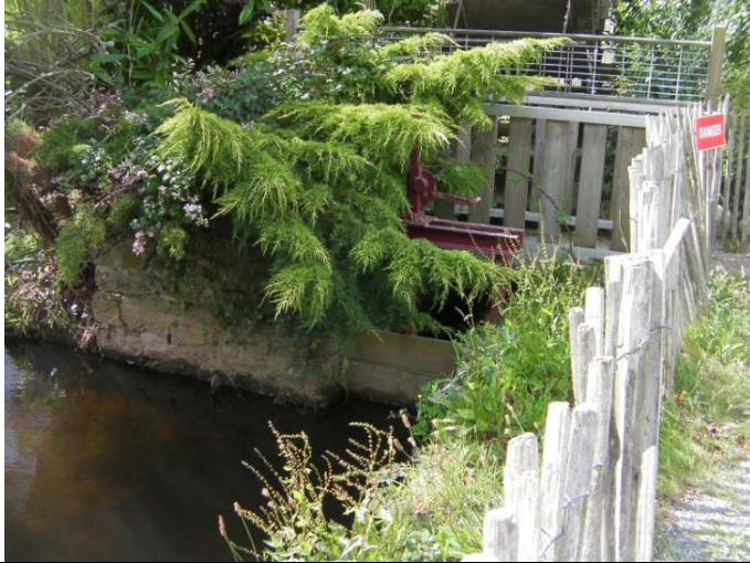
La vanne d'alimentation du canal en rive gauche
