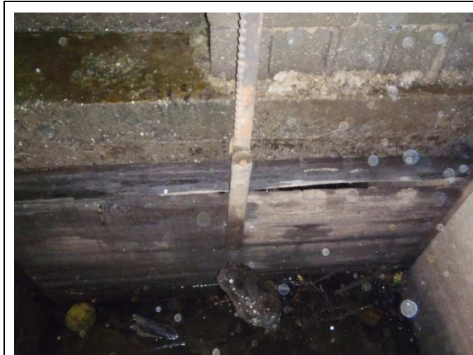
Figure 8 : Vannes de l'ouvrage de régulation (FISH PASS)
