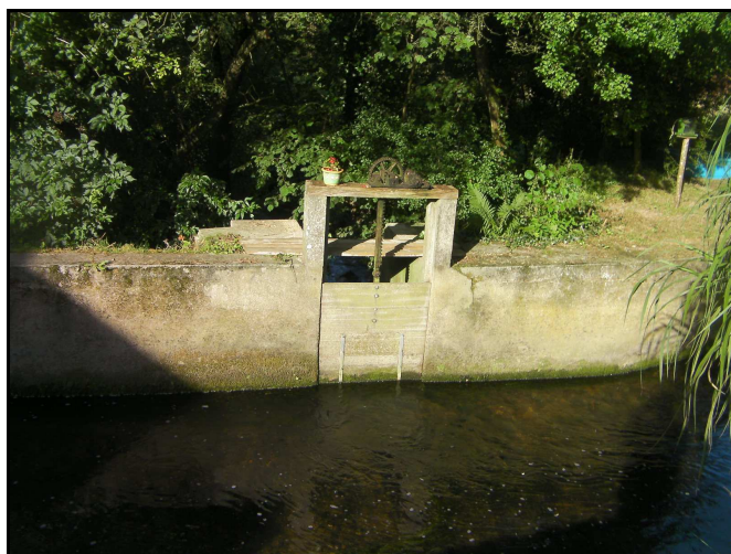
Figure 26 : Vanne de décharge du bief (gauche) et emplacement de l'ancienne roue du moulin en aval de la chute (droite, FISH PASS)
