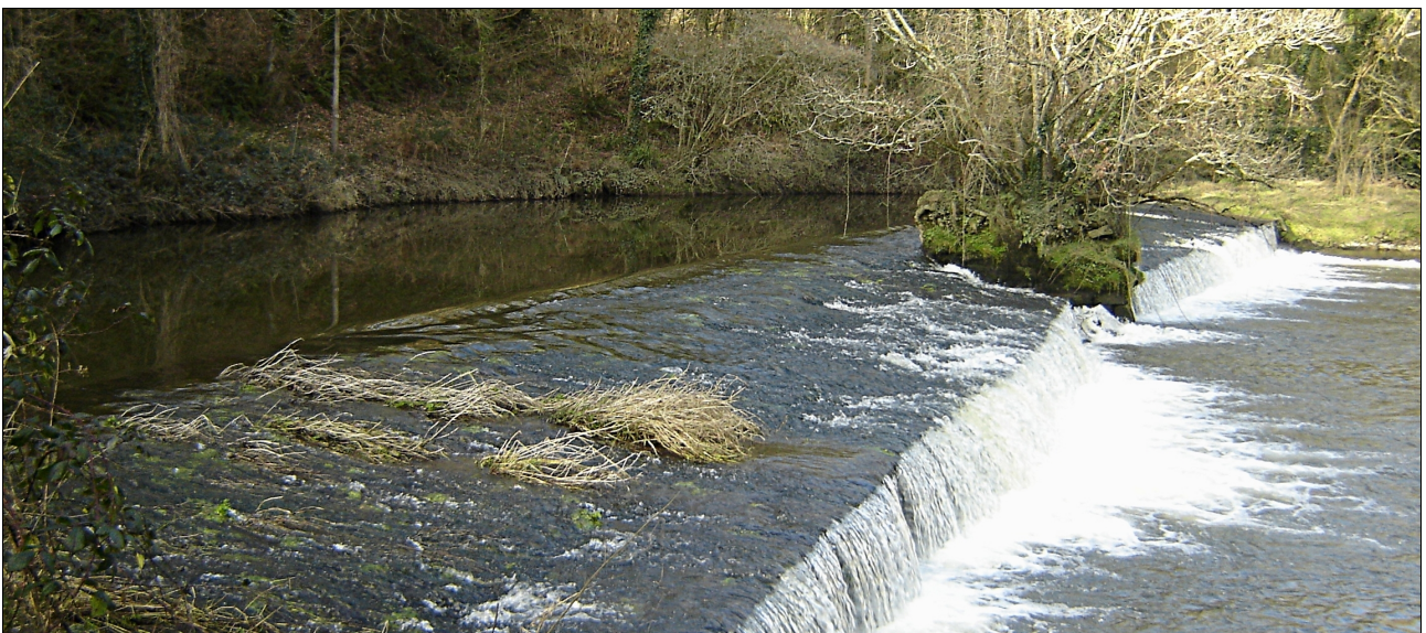
Barrage du Moulin du Houël avant les travaux © Hubert Catroux
