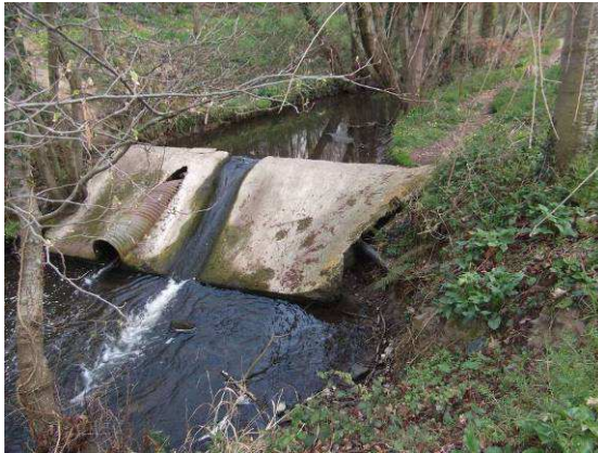
Seuil de la prise d'eau de l'étang de l'Ecluse avant travaux
