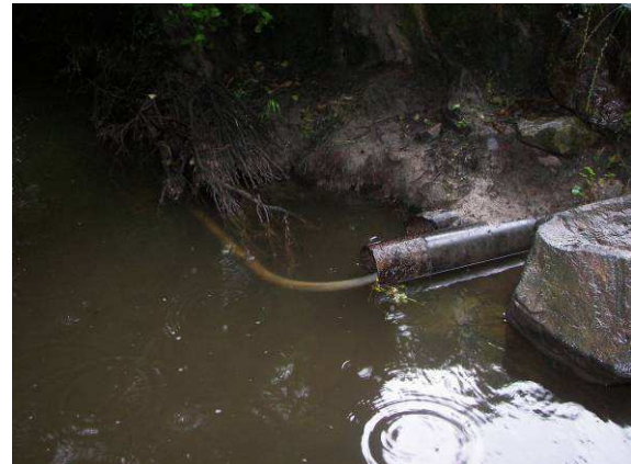
Prise d'eau de l'étang de l'Ecluse après travaux
