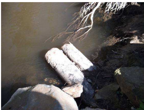
Prise d'eau de l'étang de l'Ecluse avant travaux
