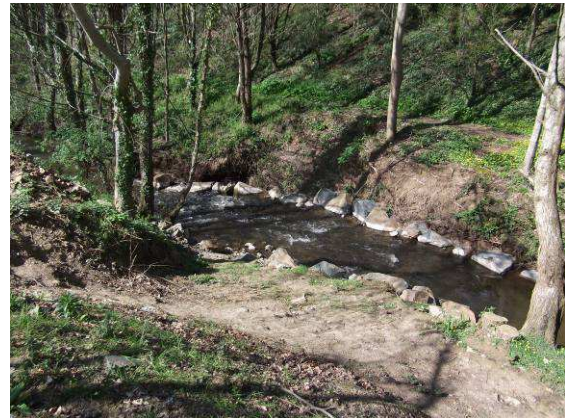
Seuil de la prise d'eau de l'étang de l'Ecluse après travaux
