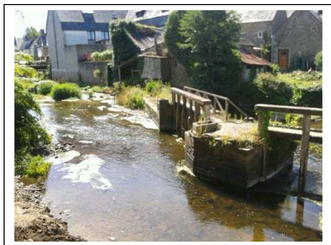
Site à l'étiage vannes enlevées Lame d'eau étalée et peu profonde
