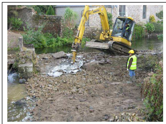
Démontage du déversoir Pierres + béton
