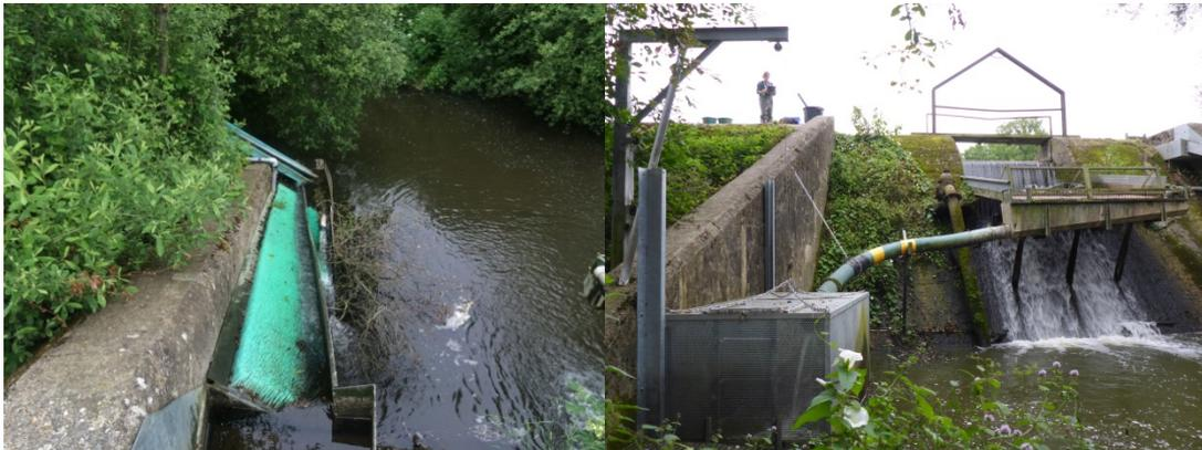
Figure 13 : Passe et piège sur le barrage de Pont-es-Omnès (FISH-PASS)
