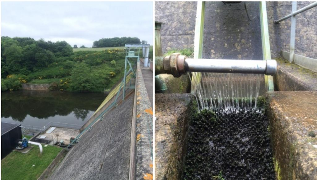
Figure 14 : Vue de l'ascenseur et de la passe à anguille du barrage de Bois Joli (FISH-PASS)
