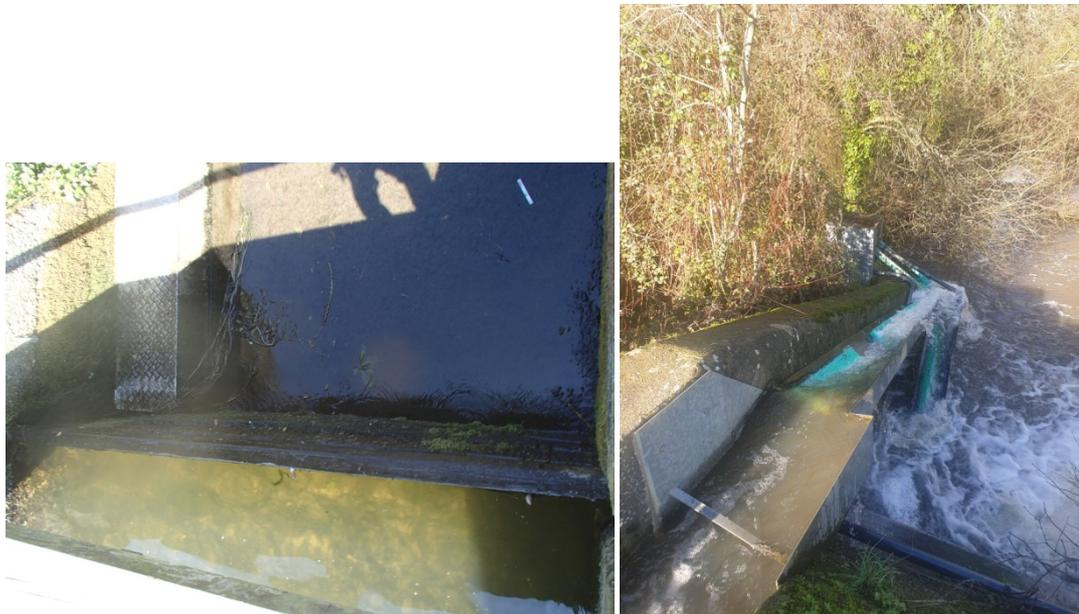
Figure 71 : Absence de surverse à Pont es Omnès. Tapis brosse manquant sur la passe de montée (Fish-Pass)
