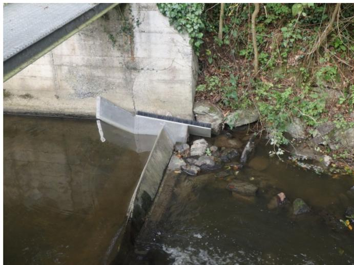
Figure 15 : Passe à anguilles sur la station de jaugeage de Pleslin-Trigavou (FISH-PASS)
