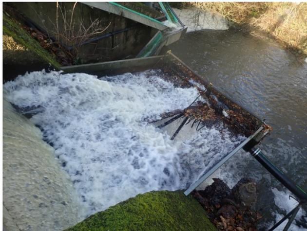
Figure 56 : Grille de dévalaison après la rupture d'un pan de grille après le premier pic de crue (Fish-Pass)
