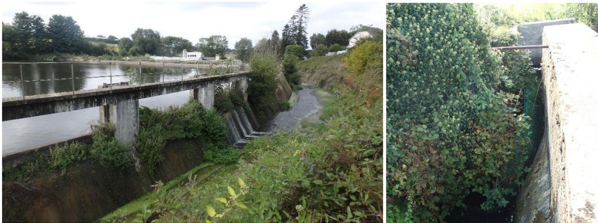
Figure 11 : A gauche, vue aval du barrage de Pont Avet et à droite sa passe à anguilles (FISH-PASS)
