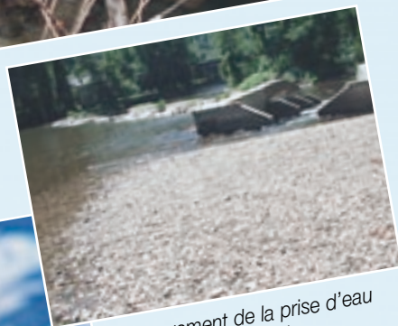
Colmatage de la prise d'eau d'une passe
