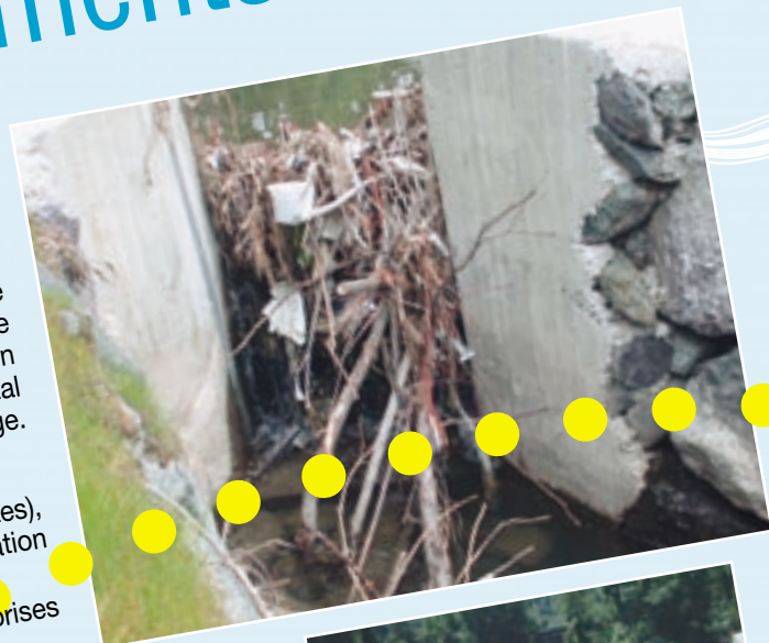
Colmatage de la prise d'eau d'une passe
