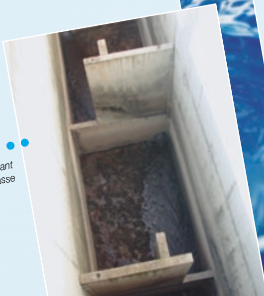
Colmatage des grilles de la prise d'eau d'une passe à bassins...
