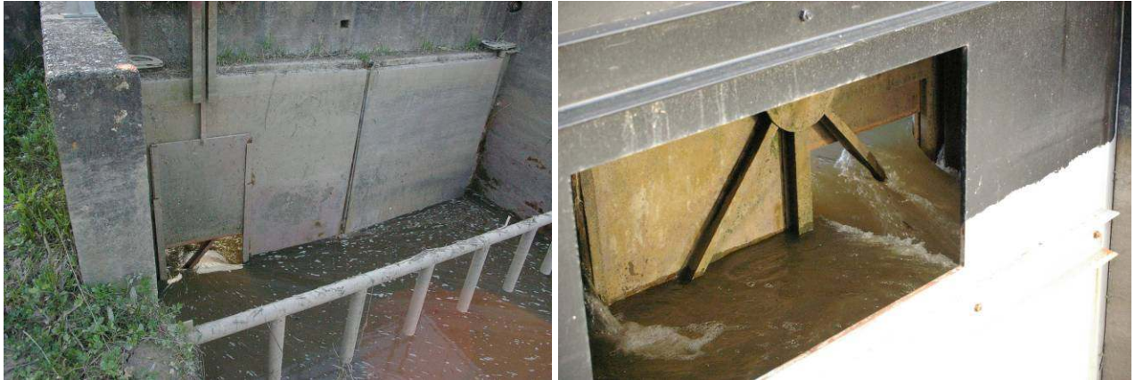
Figure 9 : Vantelle ouverte sur les portes à flot d'Issan, vue de l'aval et de l'amont. Source : MIGADO, 2011
