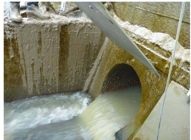
Vue du clapet à marée contrôlant l'UG3, bloqué en position ouverte + vue de la buse en amont (vue en marée basse)
