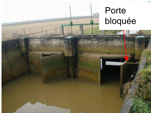
Exemple de porte bloquée sur une Jale (photo ECOGEA)
