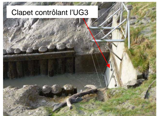
Vue des clapets à marées (clapets à marées non bloqués) (photo : MIGADO)
