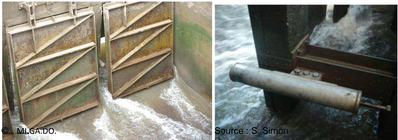
Figure 7 : Raidisseurs installés sur les clapets de la jalle du Breuil. Source : MIGADO et S. Simon, 2010
