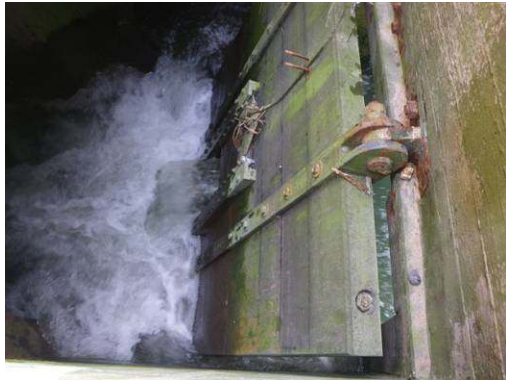
Vantelle installée au niveau du clapet de l'ouvrage estuarien de la Scie (photo : ECOGEA)
