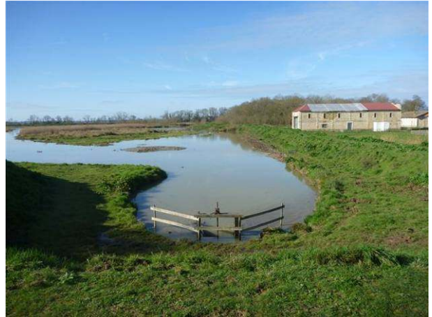
Le système de vannage et de madriers en amont contrôlant le niveau d'eau dans le marais
