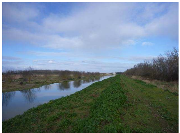
Chenaux d'enceinte dans le marais
