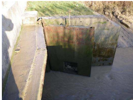
Vantelle ouverte de la porte à flots de La Maréchale
