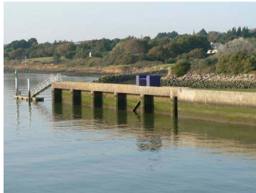
Photo de la passe à anguilles au barrage d'Arzal sur la Vilaine (photo : Fish Pass)
