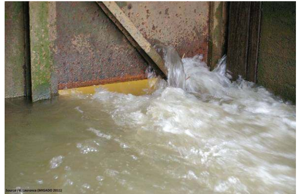
Vantelle de la porte à flots de la Jalle de La Maqueline (photo : MIGADO)
