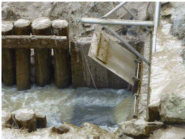
Vue du clapet à marée contrôlant l'UG3 bloqué en position ouverte (vue en marée basse)
