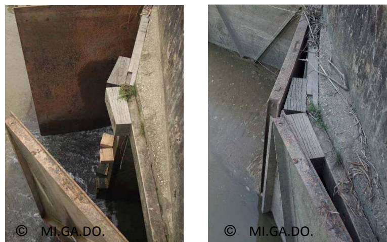
Figure 5 : Des cales en chêne au niveau des portes à flot d'Arcins, à marée basse (portes à flot ouvertes) et à marée montante (portes à flot fermées laissant une ouverture de 10cm sur toute la hauteur). Source : MI.GA.DO., 2009
