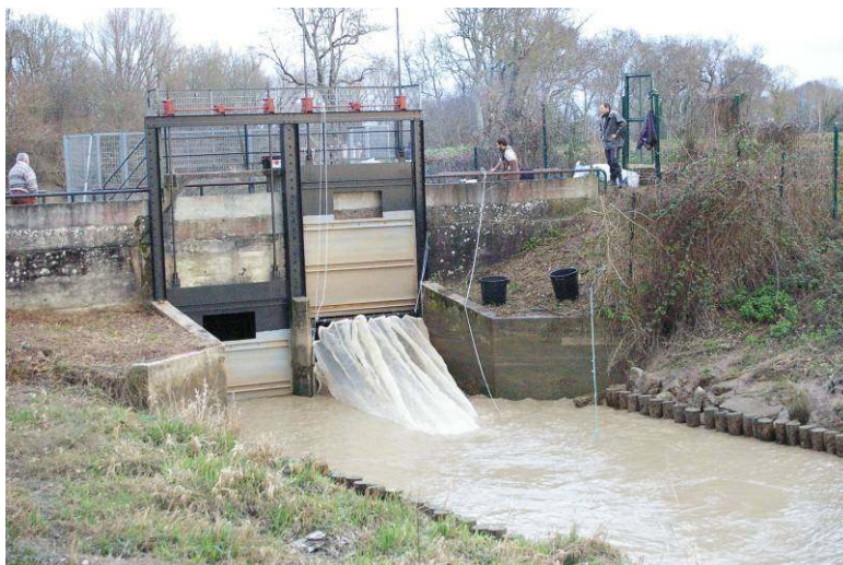
Figure 13 : Filet de pêche utilisé pour les pêches expérimentales, en cours d'installation sur le cadre de fixation et installé en amont de l'ouvrage, au niveau de la vanne rive droite sur la Maqueline (les autres vannes étant fermées). Source : MI.GA.DO., 2011.
