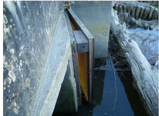
Porte à flots du marais d'Arcins laissée entrouverte par la mise d'une cale (photo MIGADO)
