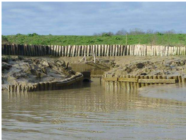
Vue des ouvrages hydrauliques depuis l'estuaire
