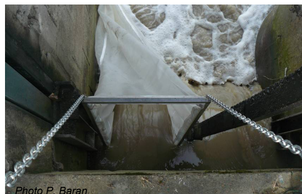
Dispositif de filtration des entrées par surverse. Relevé toutes les 15' au cours de l'envoi.
