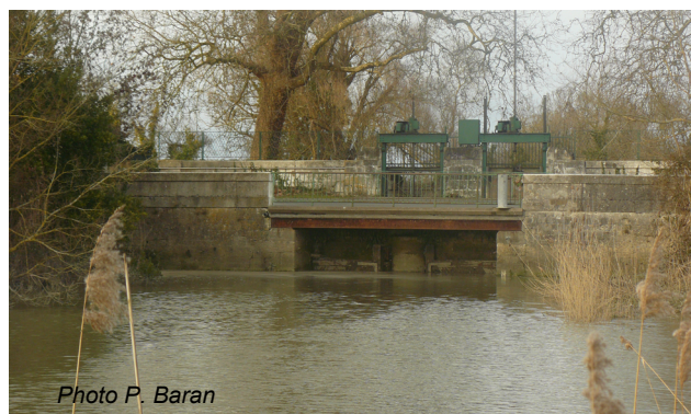
Vue aval de l'ouvrage de Charras (portes à flot fermées à pleine mer)
