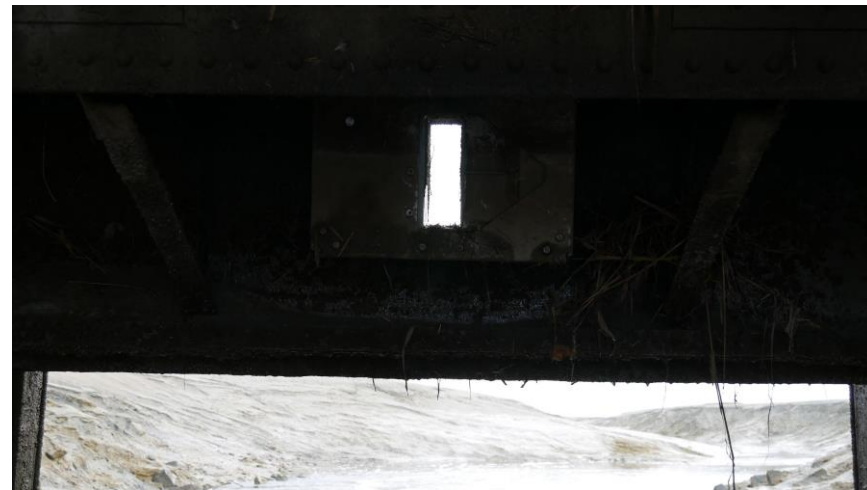
Vantelles sur l'ouvrage du Canal des allemands (35)
