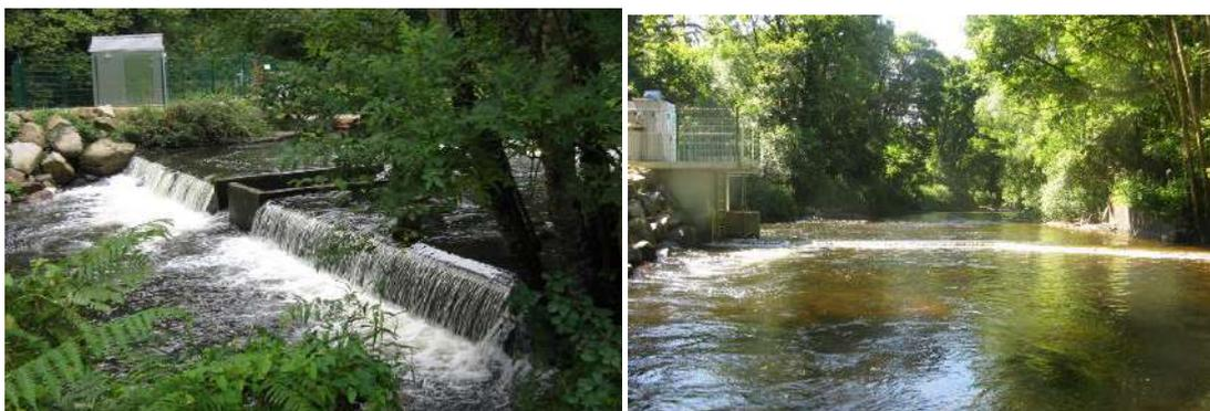
*Abaissement des 2 seuils (1.70m) de la prise d'eau potable de la station de pompage de Traou Long avec installation d'une pompe pour remplacer l'alimentation gravitaire d'un canal d'amenée*
