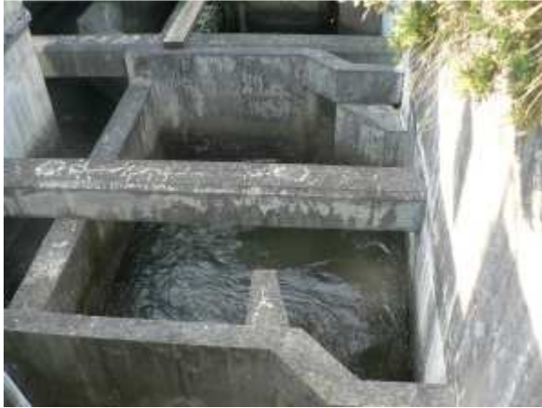
Un des bassins de la passe à bassins du barrage d'Arzal (Source : IAV)
